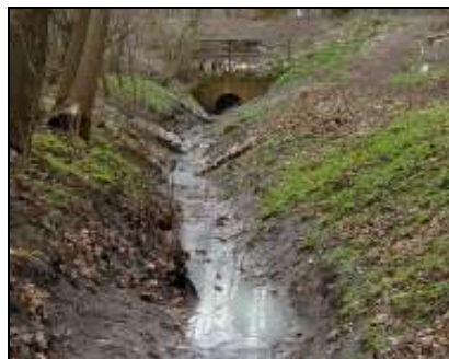
Ungeklärte Abflüsse von Strassen, Gewerbegebieten und Haushalten führen z.T. zu einer starken Belastung der Gewässer.
