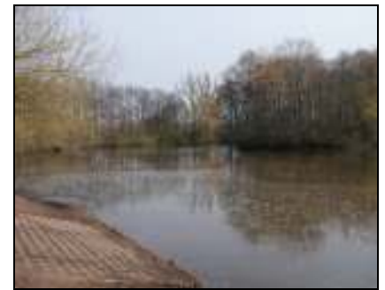
Die Ufer von Regenrückhaltebecken sind oft betonverschalt und bieten Gewässerorganismen wie z.B. Fischen und Amphibien keinen geeigneten Lebensraum.
